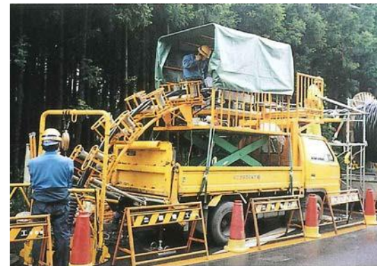
—道路上でのケーブル引入作業—
