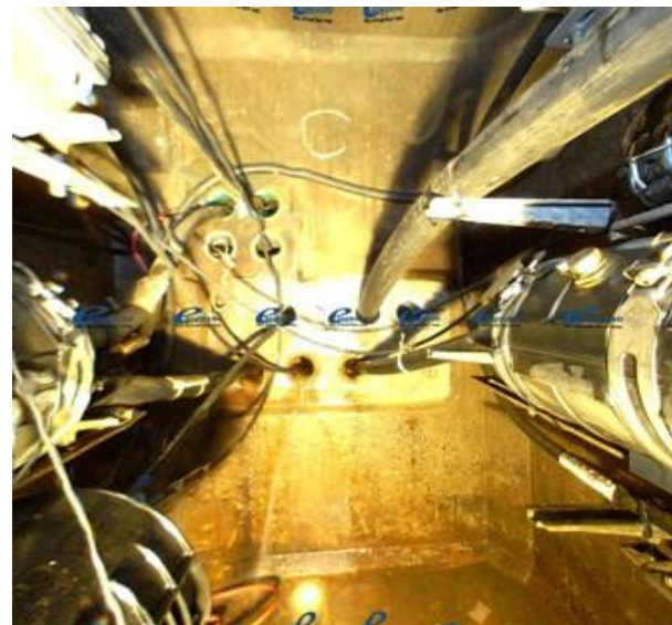
【マンホール内の点検】
