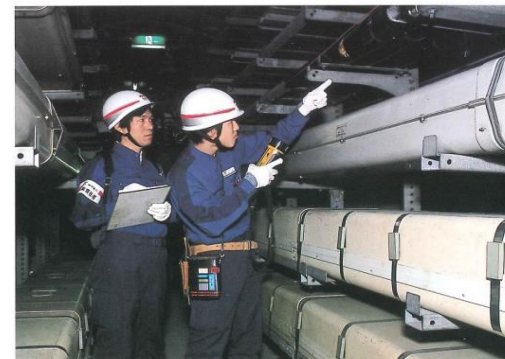
—道路下での点検状況—
