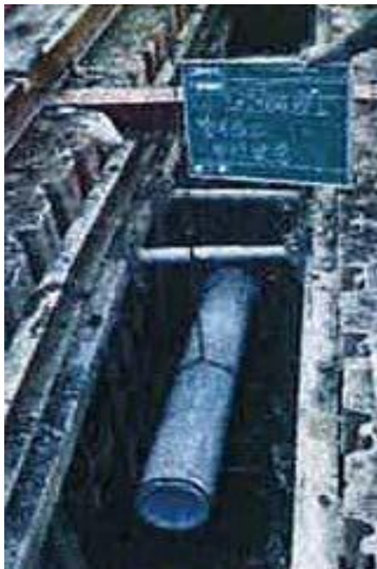
管路新設状況写真
