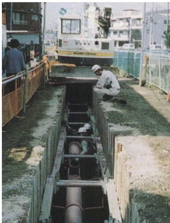
管路取替状況写真
